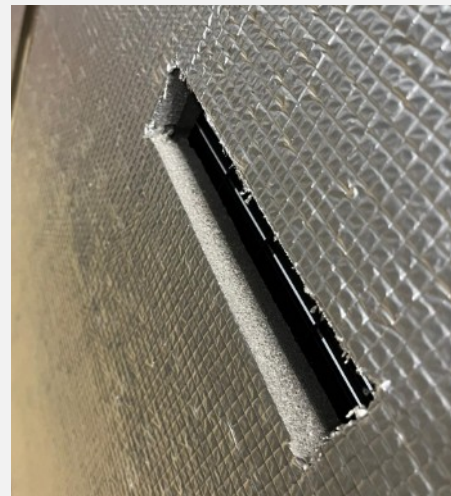
1 cm d'isolation dans les panneaux d'habillage + thermoréactif
